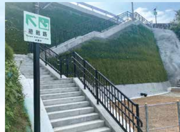
避難路の盛土にもテンサー®
