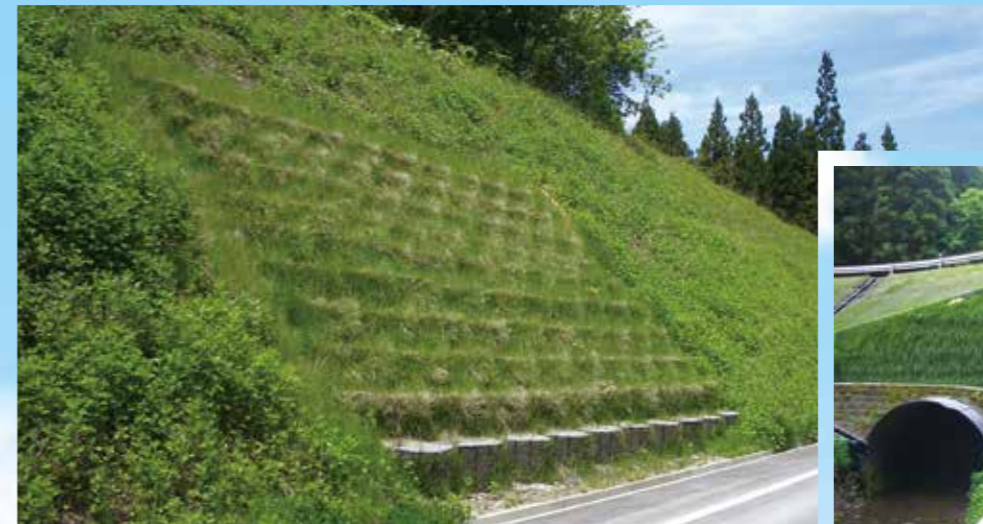
切土・盛土はテンサー® で補強と緑化
